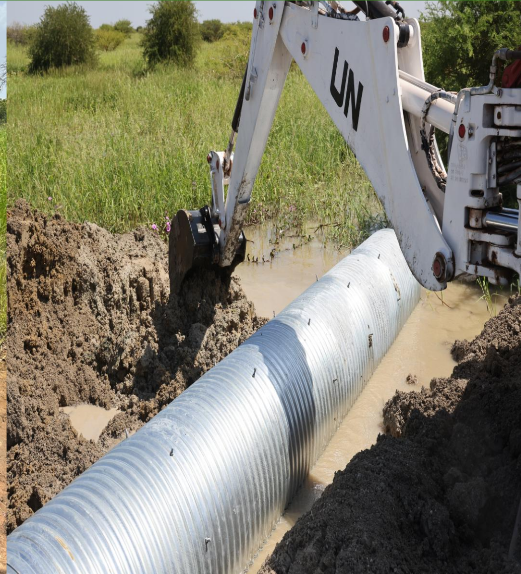
Des ingénieurs indiens réparent la route de ravitaillement endommagée par les inondations entre Malakal et Renk (UNMISS, Sud Soudan)
